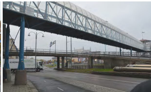
▲ Programområdet idag - från vänster Nils Ericsonsplatsen, Korsningen Kanalgatan/Kanaltorget och slutligen vy mot Operan och Kanaltorget.
